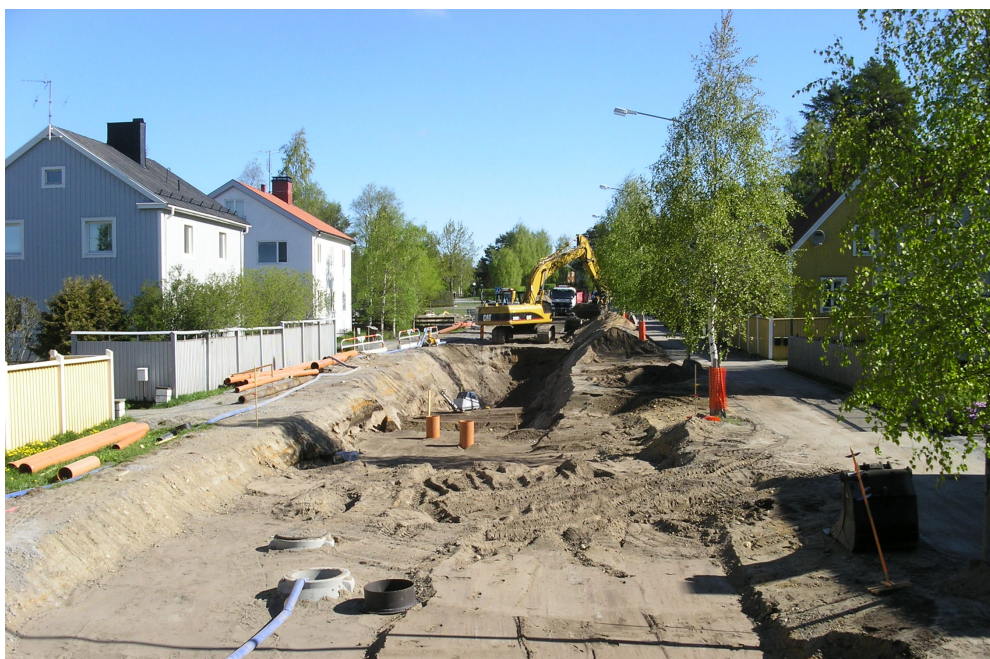
Ombyggnation av gata då även ledningar för vatten och avlopp förnyas.
