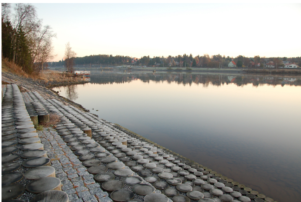
Foto med vy över Umeälven, i närheten av avloppsreningsverket på Ön.
