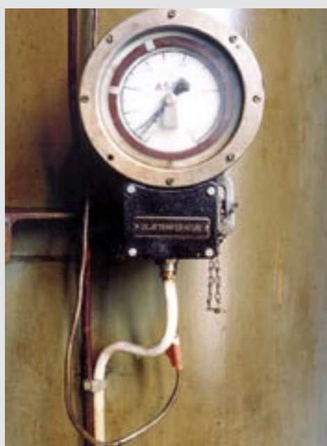
Termometer med kapillärrör innehållande kvicksilver. Fabrikat ASEA.
