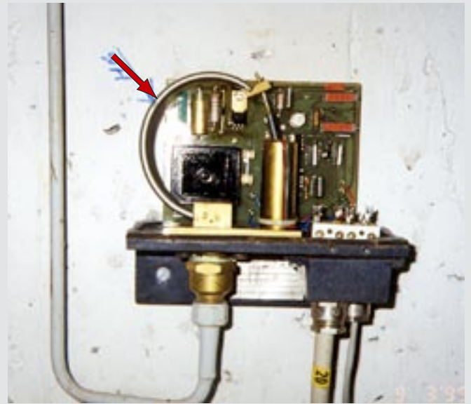
Trycktransmitter. Kan innehålla dolt kvicksilver. Fabrikat NAF.
