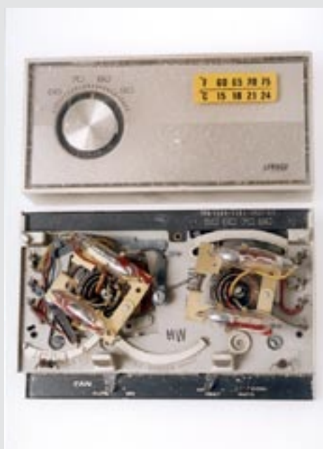
Rumstermostat med ventilationsstyrning. Fabrikat Lennox.
