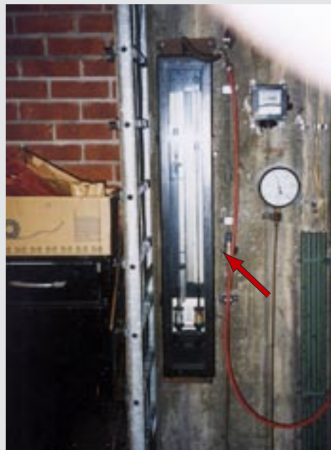
Differens-trycksmätare med pelarvisning.
