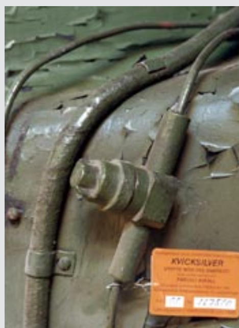
Om det finns uttag för påfyllning av kapillärrören, innehåller de kvicksilver.
