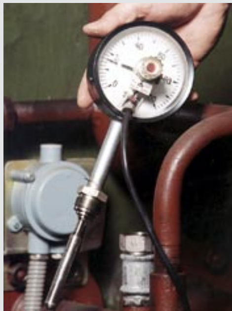
Termometer med dykrör innehållande kvicksilver. Fabrikat NAF.
