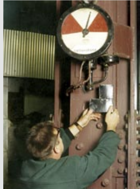
Läckage från flödesmätare är så vanligt att man förr kunde skaffa behållare för uppsamling av kvicksilver som monterades på mätaren.
