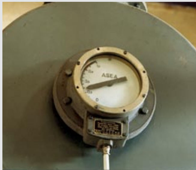
Volymmätare med inbyggd brytare. I detta fall innehåller volymmätaren i övrigt inget kvicksilver. Fabrikat ASEA
