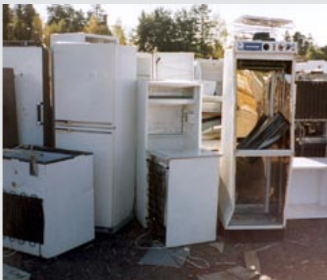
I samband med att CFC tas omhand vid skrotning av kylmöbler demonteras även kvicksilverkomponenter.
