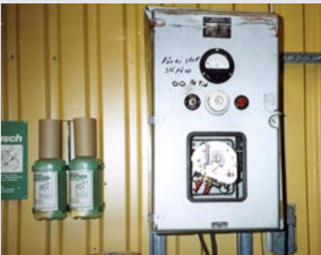
Batteriladdare innehållande frånslagsvippor. Fabrikat Tudor.
