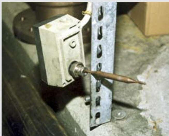
Termostat med demonterat dykrör. Den frilagda, på bilden synliga, känselkroppen kan i vissa fall innehålla kvicksilver, vilket dock inte denna gör.
