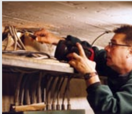
Kvicksilverinventering av spill från två våningar ovanför.
