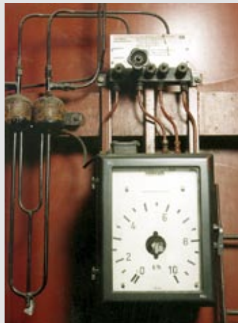
Flödesmätare. Obs! Kviksilver finns både i mätaren och behållarna till vänster om mätaren.
