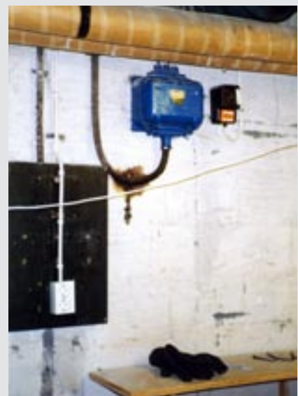
Trappautomat monterad på väg.
