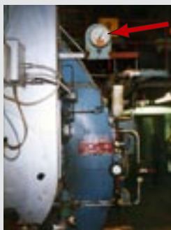
Termometer med kapillärrör monterad på oljepanna.
