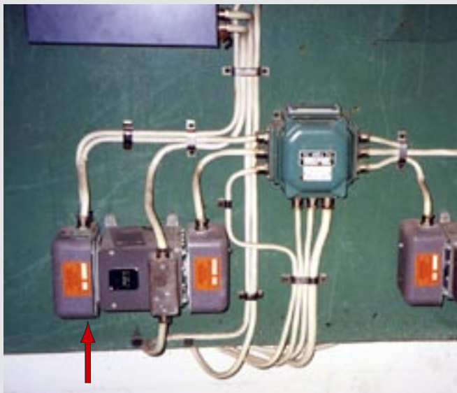
Styrdon till kylanläggning – med lock ...
