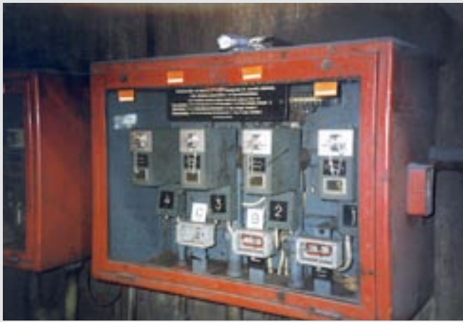
Inbyggda kvicksilverbrytare för utlösning monterade i brandsläckningsutrustning.
