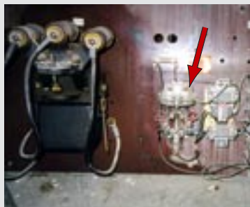
Hissautomatik med mekaniskt relä med fördröjt fränslag samt monterad vipa på brytaren för signal.
