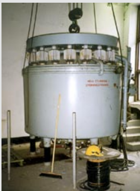
18-anodig jonventil. Fabrikat ASEA.
