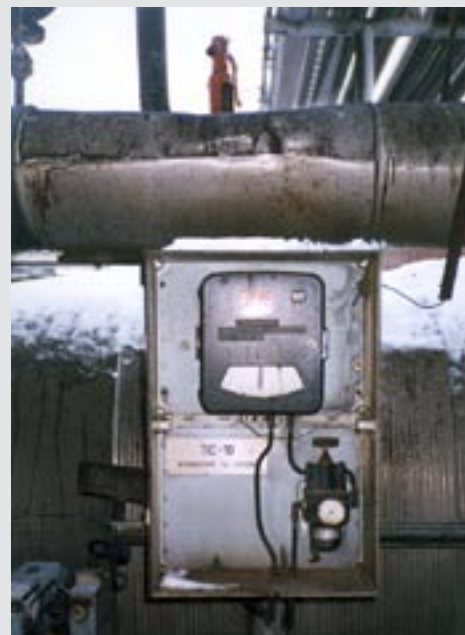
Temperatur- mätare med kapillärrör. Fabrikat NAF.
