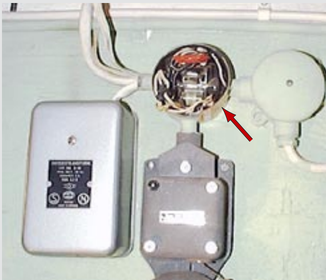
Inbyggt relä för ringsignal. Fabrikat Inveco.
