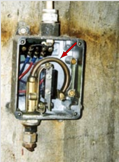
Trycktransmitter. Kan innehålla dolt kvicksilver. Fabrikat NAF.
