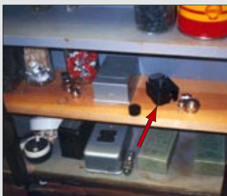
Ofta finns det någon eller några kvicksilverinnehållande komponenter som reservdel på lager. I detta fall ett Inrecorelä.
