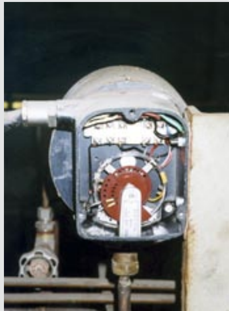
... med kontakt- ring som inne- håller kvicksilver.
