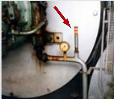
Glastermometer med kvicksilver monterad på oljepanna.
