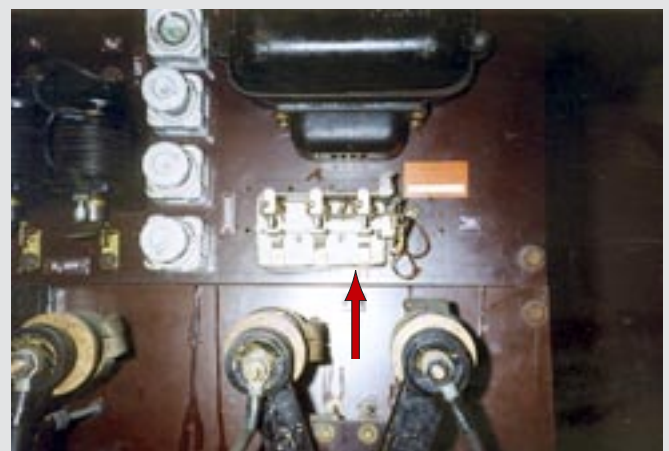
Hissautomatik med kvicksilverbrytare monterade.
