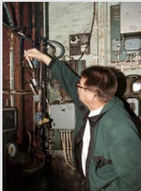
Kvikksilver i glastermometrar identifieras lättast genom att titta på spetsen.
