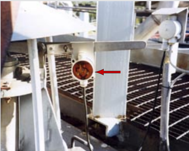
Kviksilvervipa monterad på hävarm för ventilöppning av tankar.
