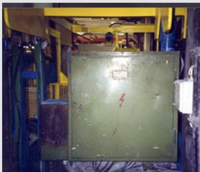
Automatiskåp till press ...
