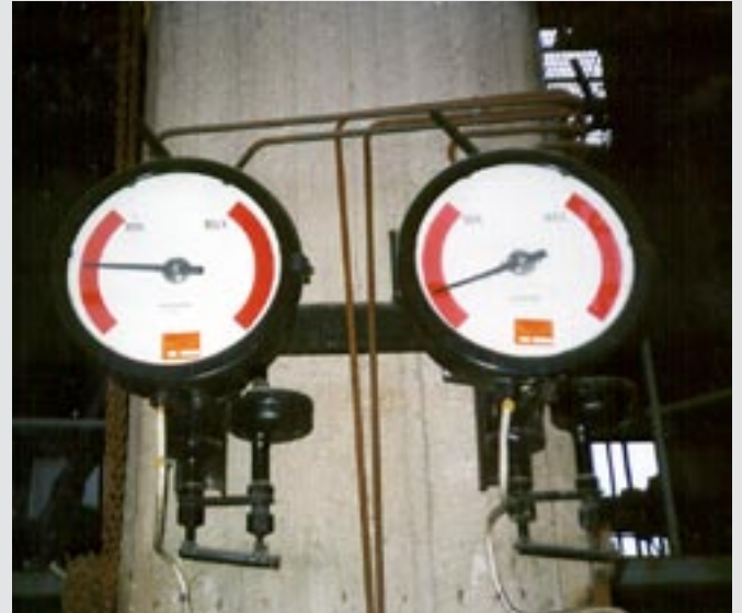
MaxMin-mätare. Fabrikat Siemens.
