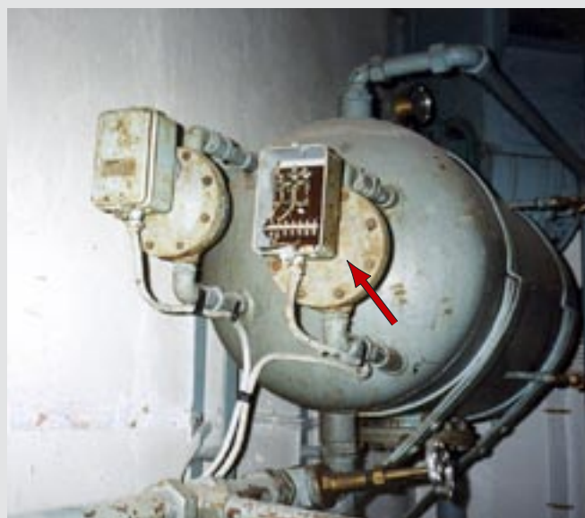
Tryckvakt monterad på övertryckskärl. Fabrikat Sauter.
