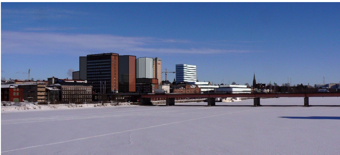
Figur 8. Fotomontage sett från Gamla Bron mot Tegsbron och Västra Strandgatan. I fotomontaget syns de vid tiden för montaget planerade byggnaden inom Kv. Magne, numera uppförd, samt föreslagen byggnad inom Brage 8. Källa: Umeå kommun
