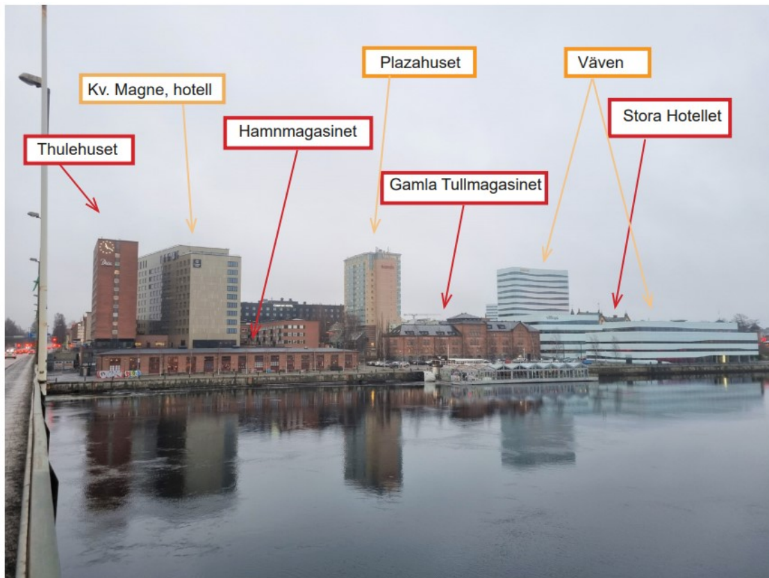
Figur 5. Foto från Tegsbron mot Västra Strandgatan. Källa: Tyréns
