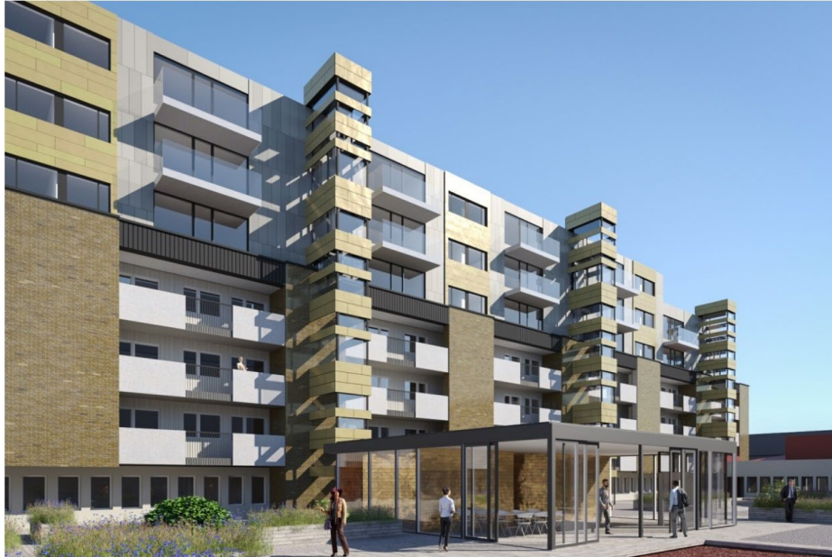
Gårdssidans på- och tillbyggnad
