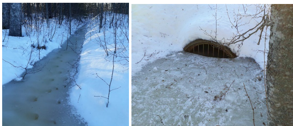
Figur 16. Bilder på befintlig bäck och dagvattenutlopp inom planområdet.
